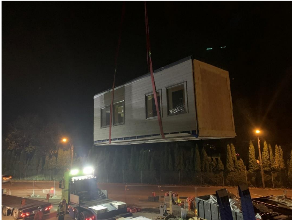
Figur 10 - Modul til montering. Tradisjonelle stropper ble benyttet ved montering, men ved demontering vil det brukes løftepunkter i taket: Bilde: Skanska Husfabrikken
