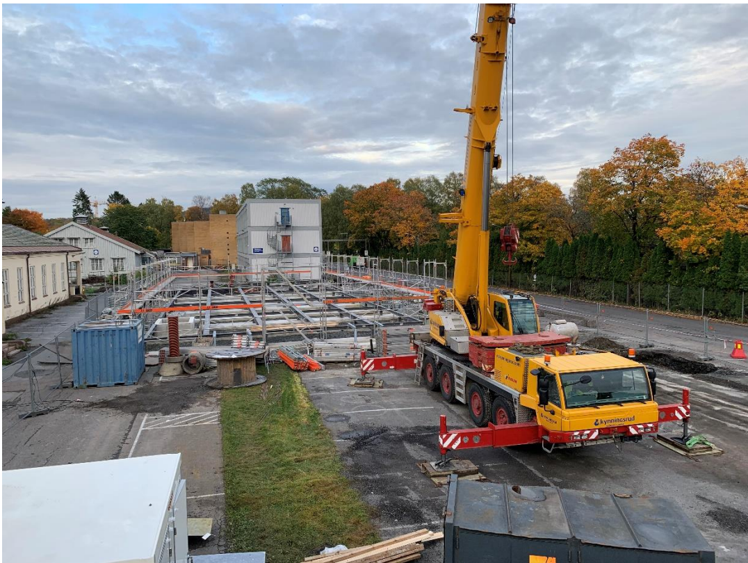
Figur 7 - Klart for modulmontasje. Foto: Skanska Husfabrikken
