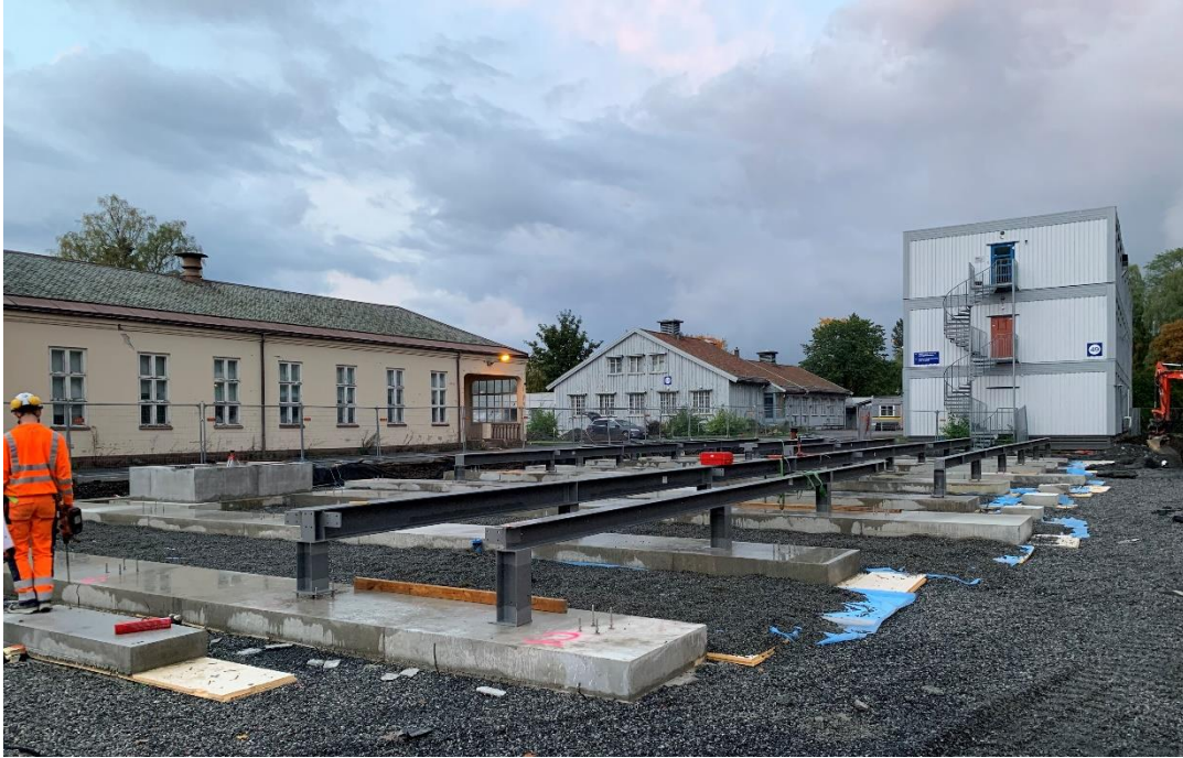
Figur 8 - Montering av fundament for moduler. Foto: Skanska Husfabrikken
