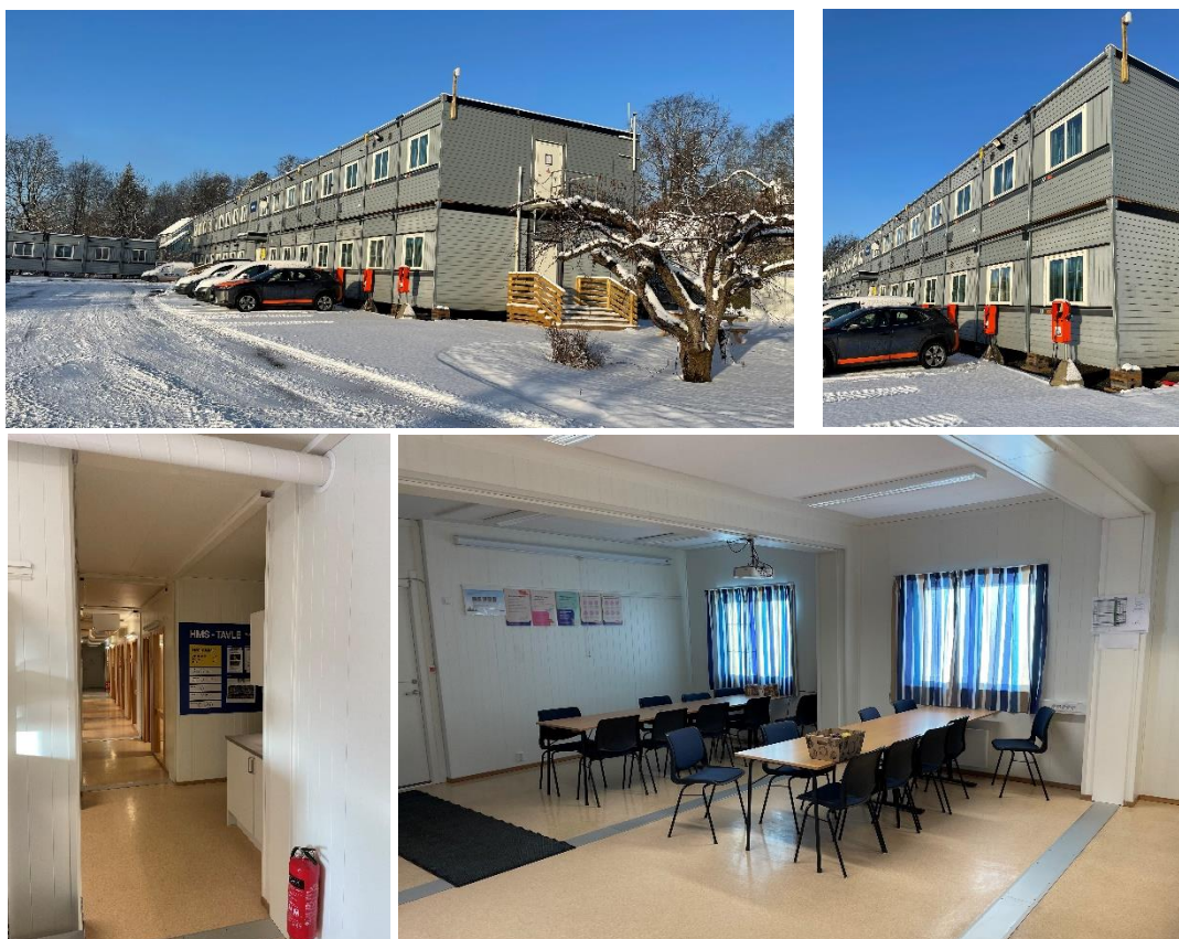
Figur 2 – Brakkerigg fra Skanska Husfabrikken, i 2 etasjer på Ramstadsletta, februar 2023. Skjøtene mellom elementene er tydelige, både innvendig og utvendig. De nederste bildene viser hvordan brakkene kan innredes fleksibelt ved å fjerne opptil 2 yttervegger. Bilder: Skanska Husfabrikken
