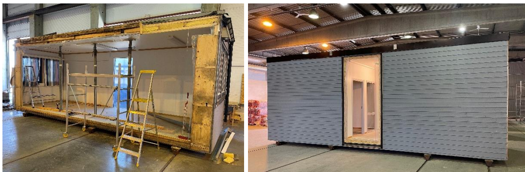
Figur 1 - Produksjon av brakkerigger hos Skanska Husfabrikken, juni 2022: Bilder: Skanska Husfabrikken
